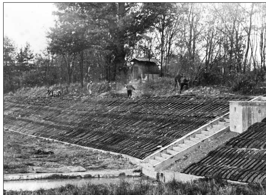
Hráz zpevněná betonovými příčnicemi.
