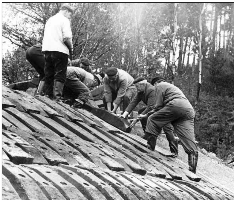
Usazování betonových příčnic.
